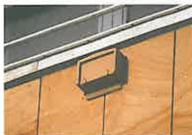
Spezialnistkasten fertig verkleidet: Terrassenbrüstung des Bürogebäudes, Fertigansicht.
