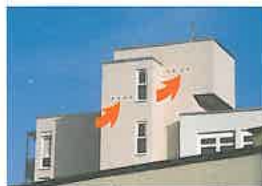
Mauersegler-Niststeine: in Wohn- und Geschäftshaus.
