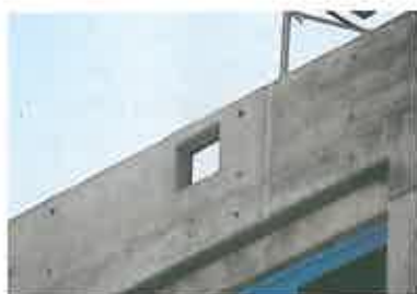
Spezialnistkasten im Rohbau: Terrassenbrüstung eines Bürogebäudes im Rohbau.
